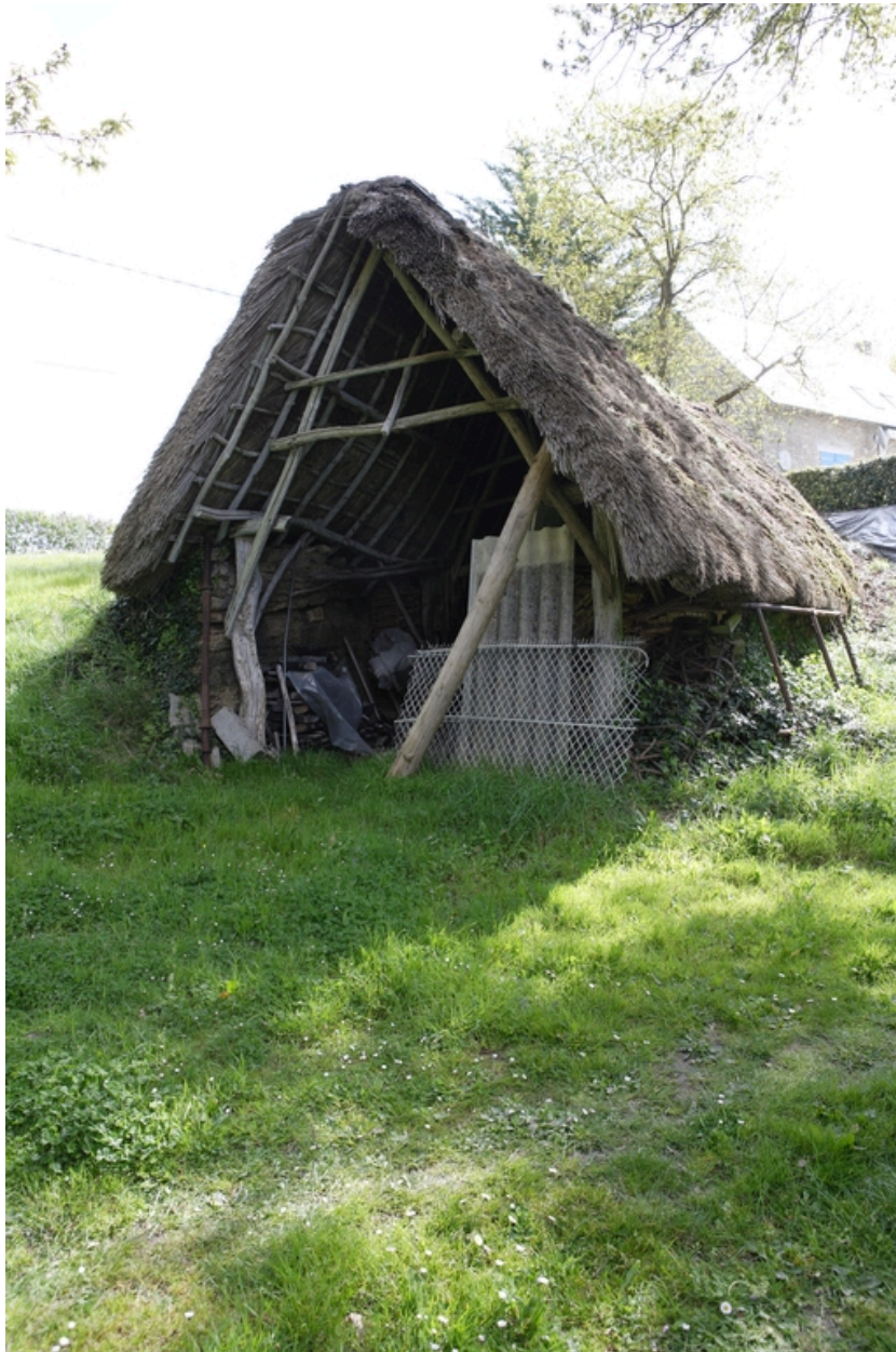
Vue de la remise depuis l'ouest.
