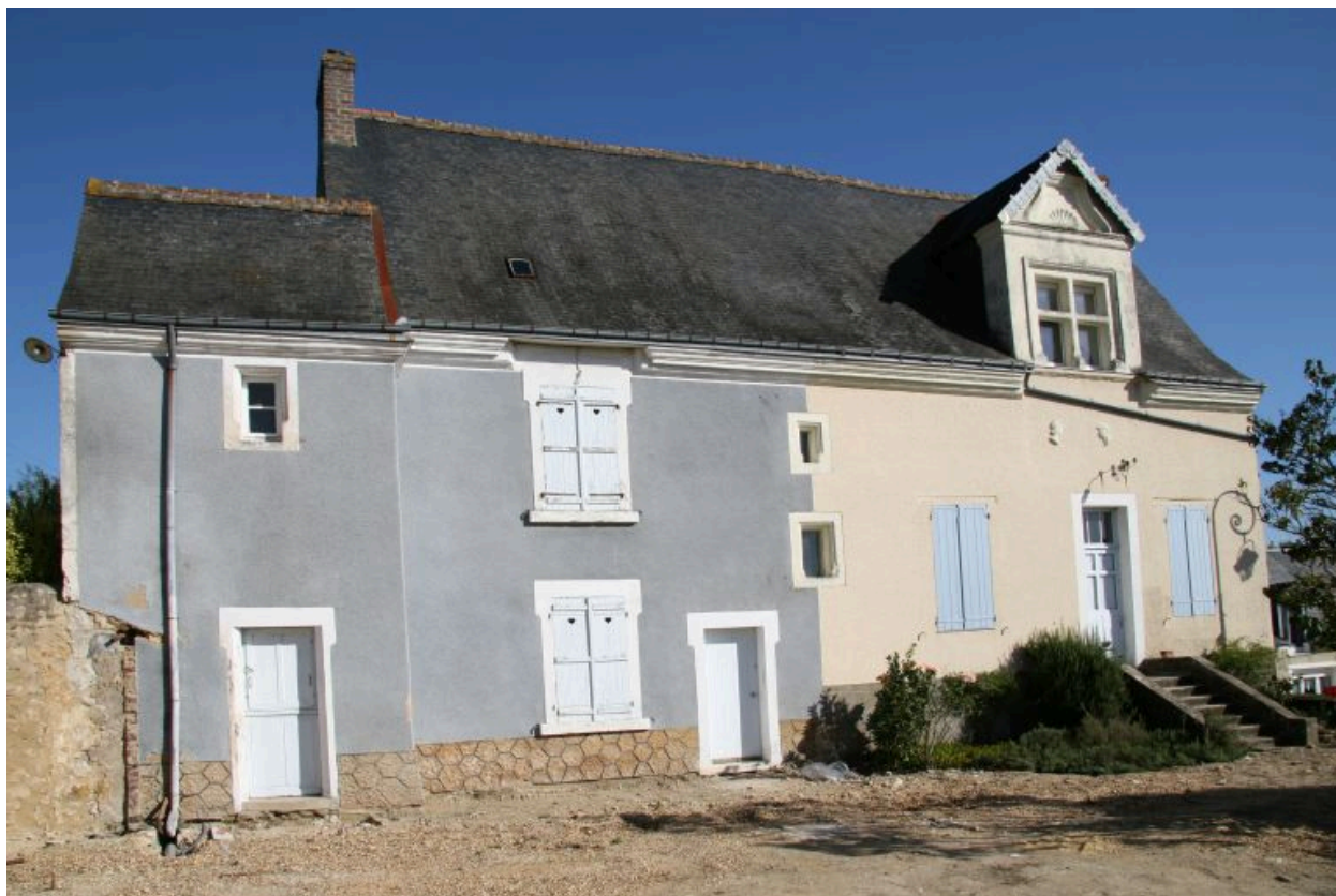
Façade antérieure sur cour.
