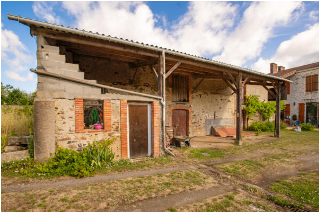
Vue générale des communs, depuis le sud.
