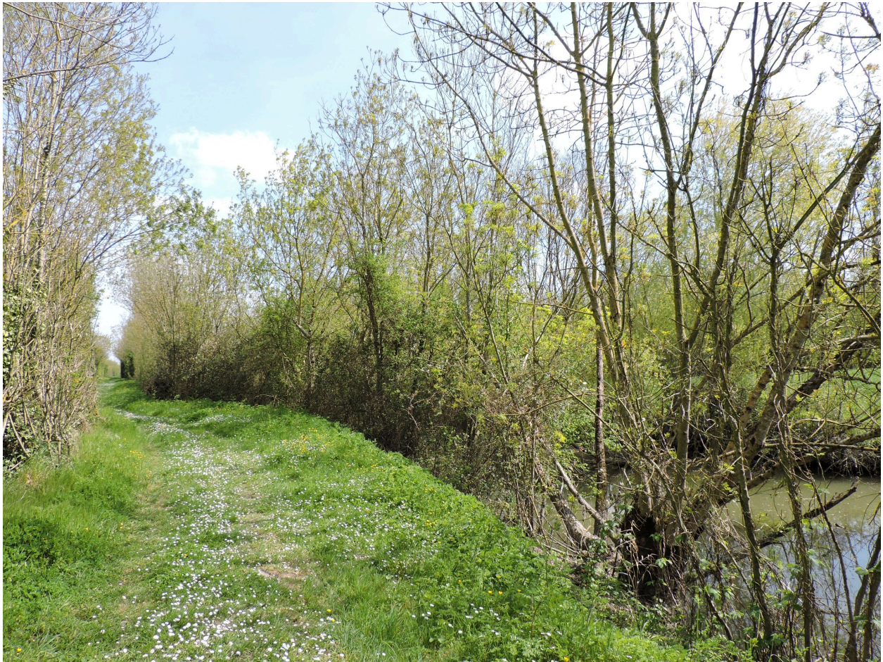
La digue à Maillé, près du canal du Pont Tord, longée à droite par le Contrebot de Vix.
