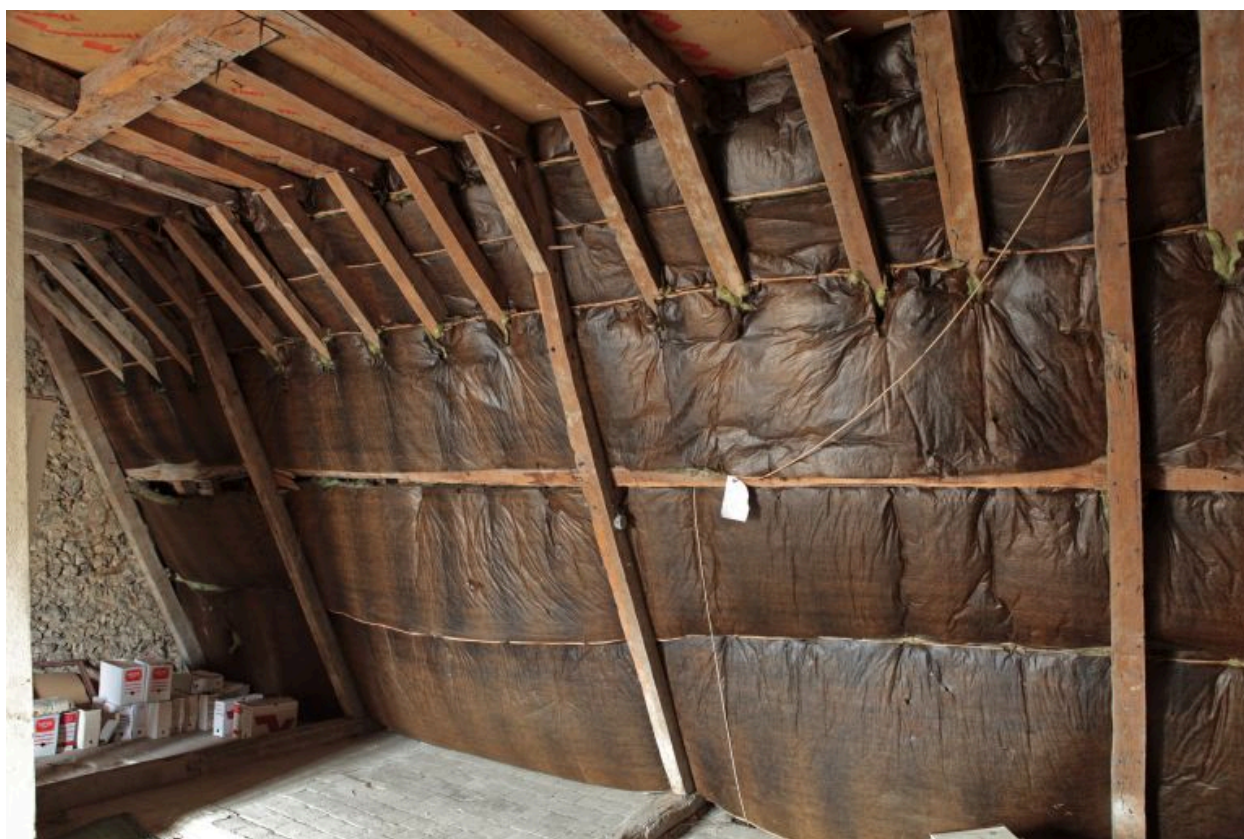
Deuxième grenier : charpente à chevrons-portant-ferme.
