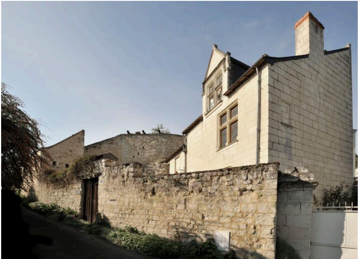
Vue sur l'ancien logis depuis la rue.
