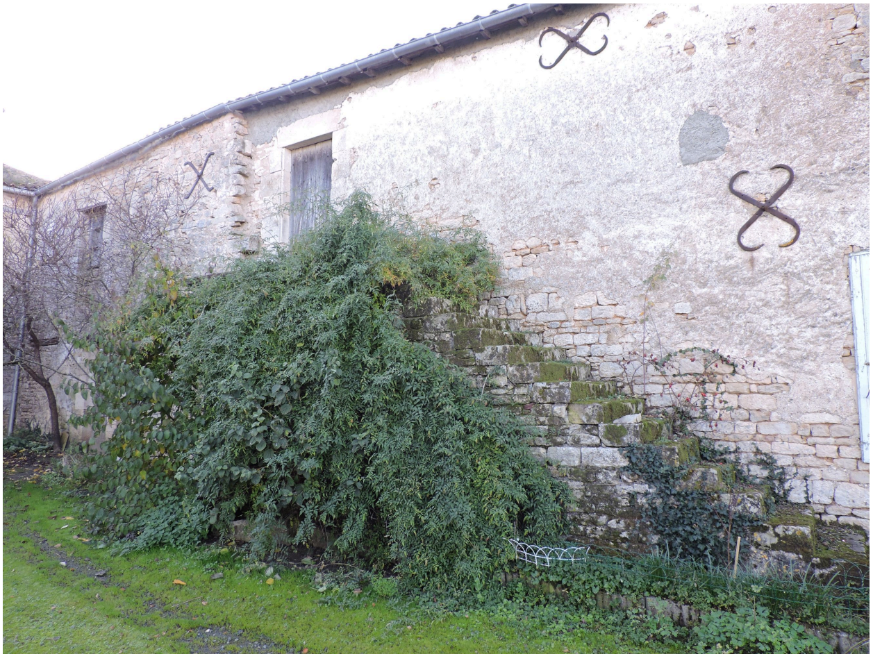
L'escalier extérieur de l'aile de communs, vu depuis le nord-est.
