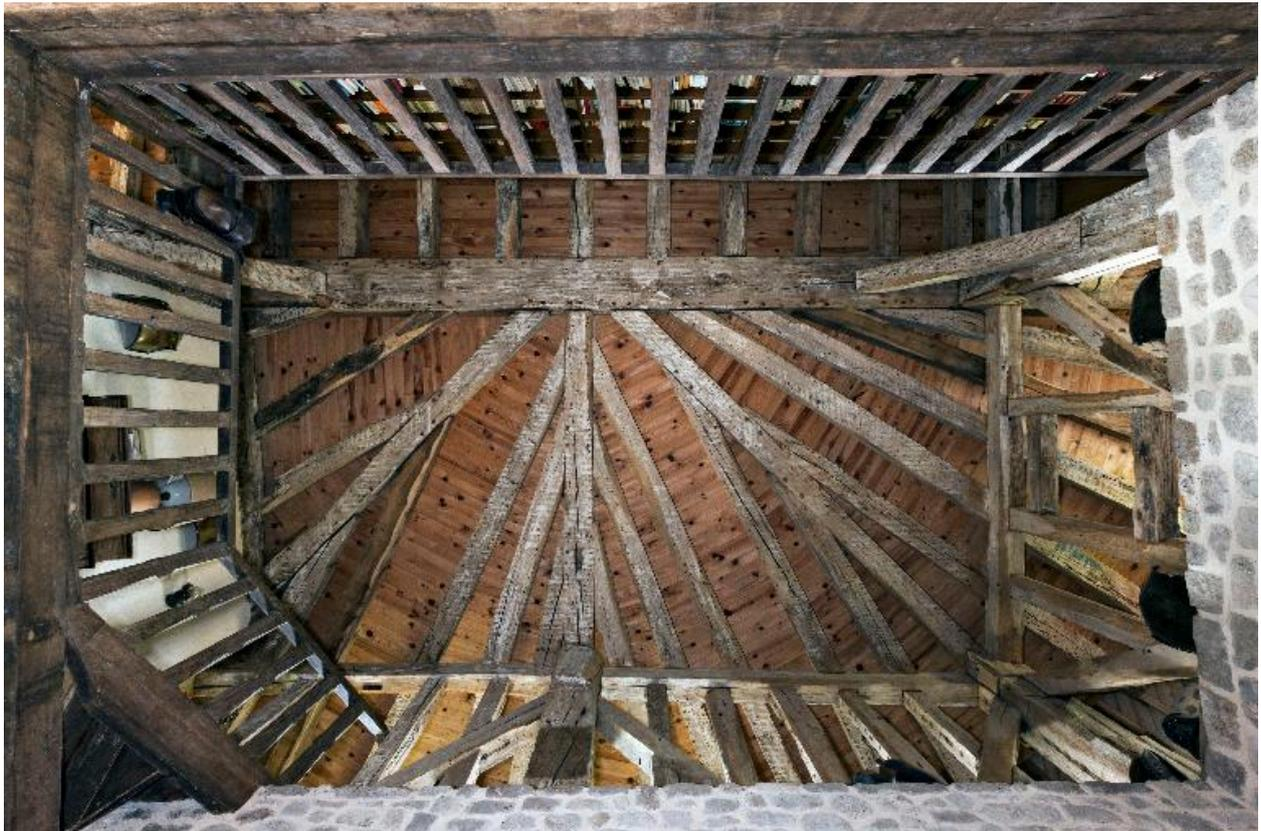
Vue partielle de dessous de la charpente de la tour nord depuis le premier étage de la tour : le niveau inférieur et l'enrayure inférieure de la charpente.
