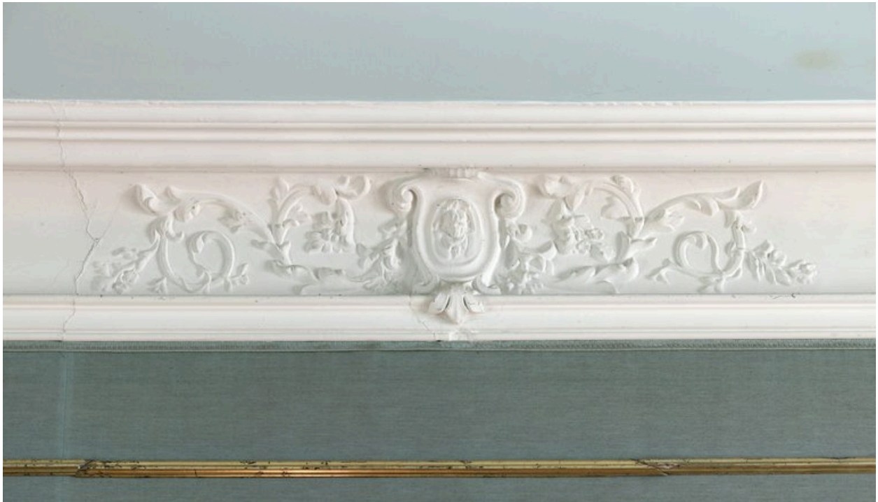
Salon à l'étage : détail de la corniche en stuc.
