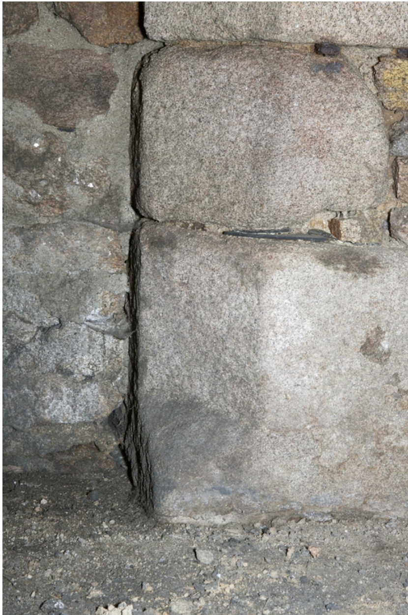
Bâtiment ouest. Détail de la base du piédroit de droite de la cheminée.
