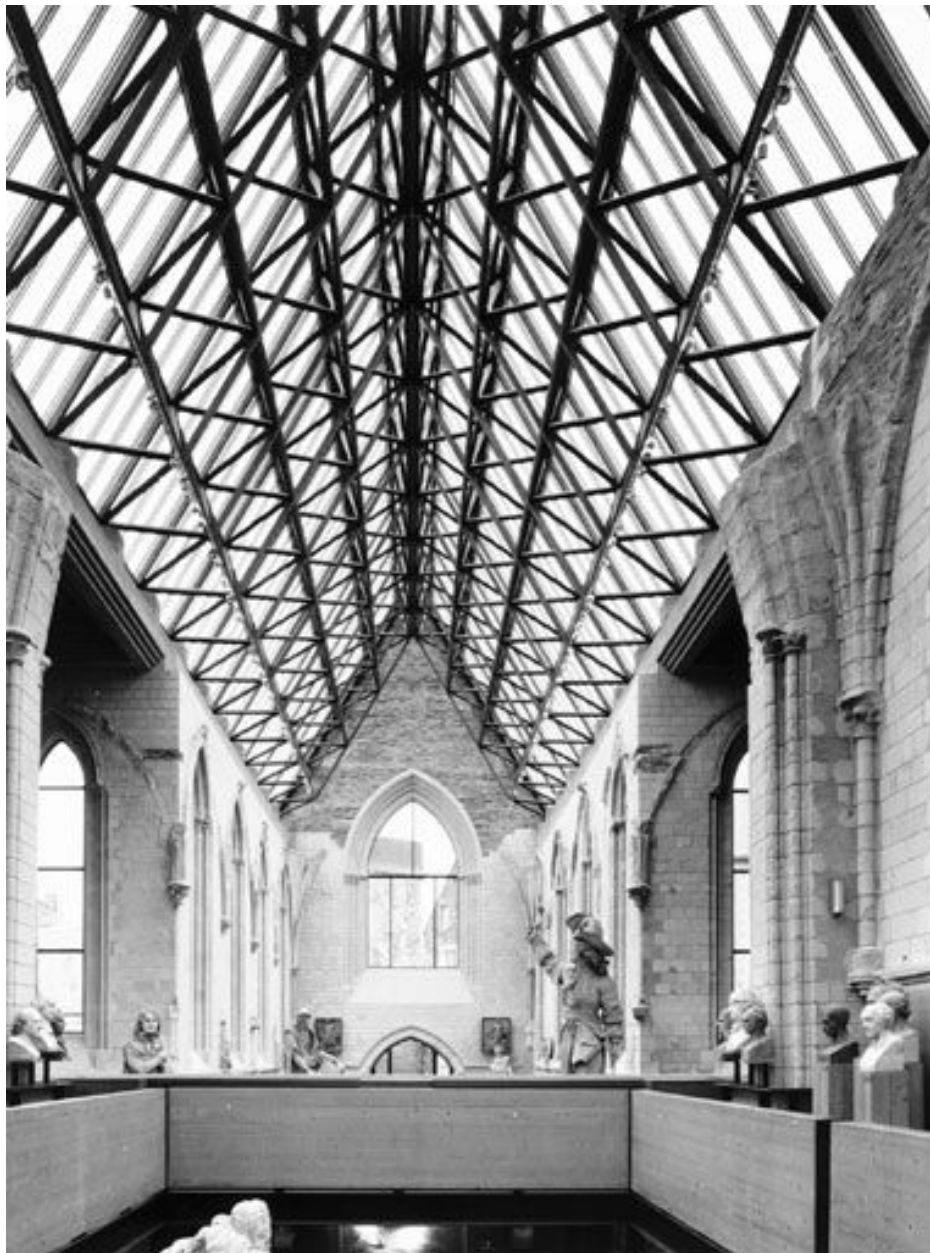
Abbatiale-musée David d'Angers : vue intérieure de la nef, vers l'ouest.
