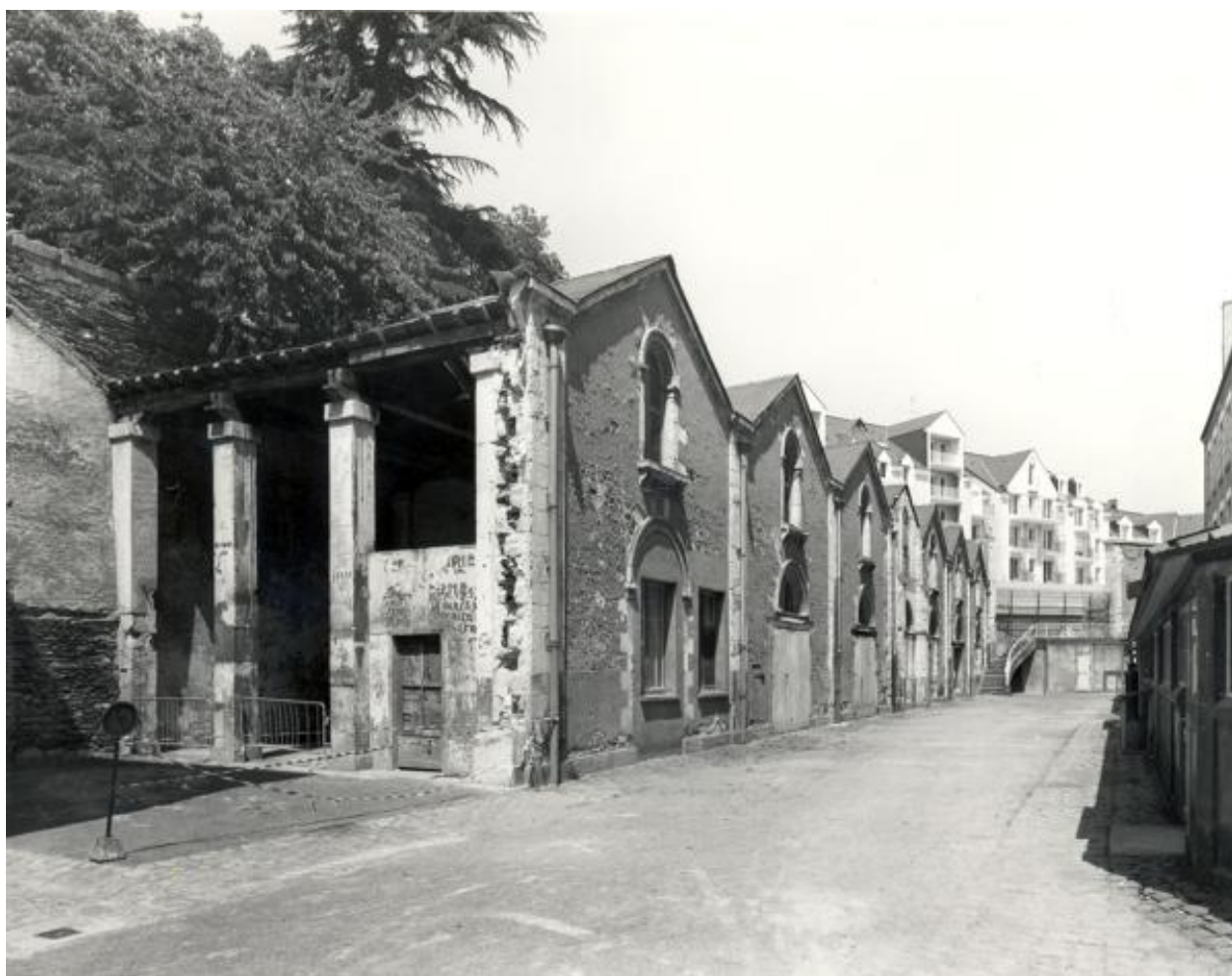
Bâtiment des écuries-remises-magasins (par Isabelle, Ch.-E.) : élévations est.
