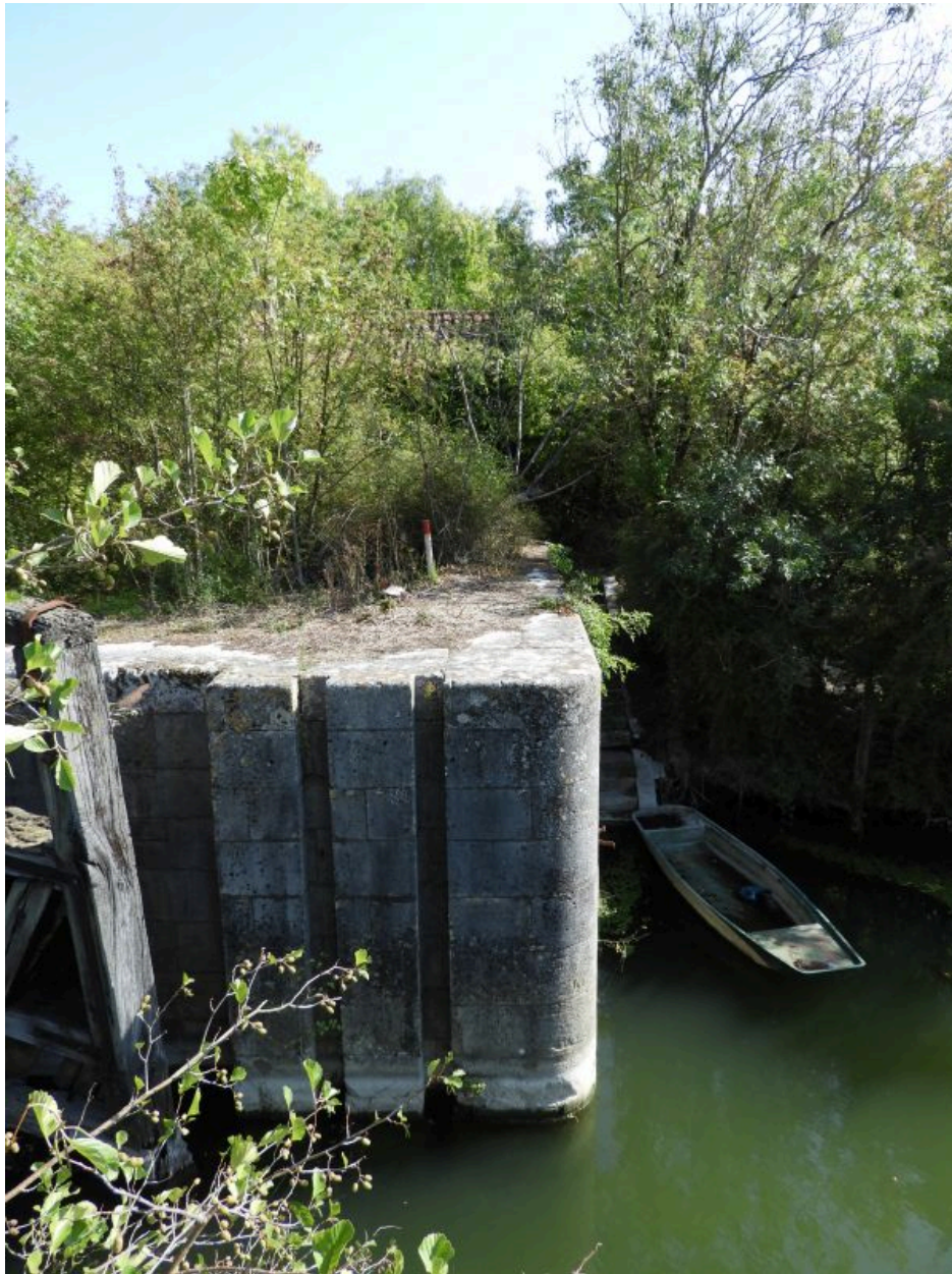
La tête aval de l'écluse, rive gauche, vue depuis la rive droite, à l'ouest.
