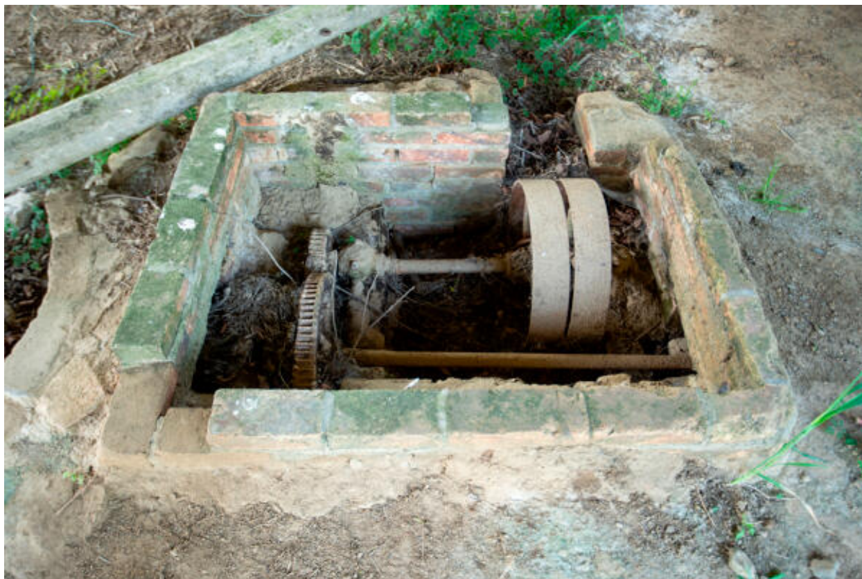
Le manège du puits artésien, détail.
