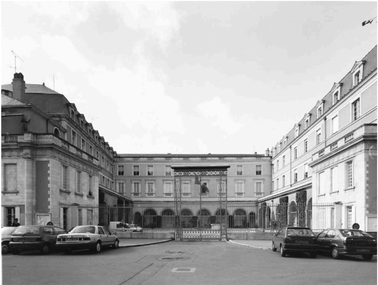
Vue d'ensemble au nord, sur la cour d'honneur.
