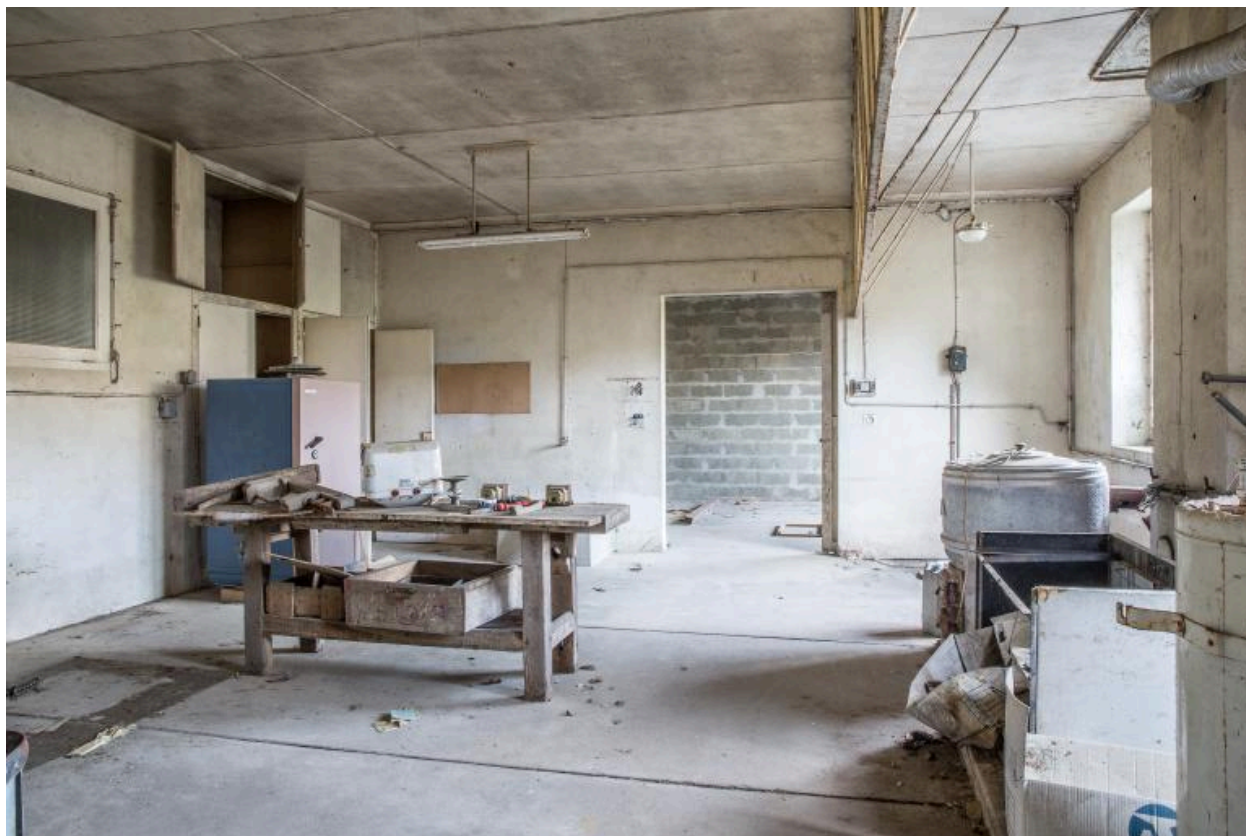
Une ancienne laverie au rez-de-chaussée de l'usine.
