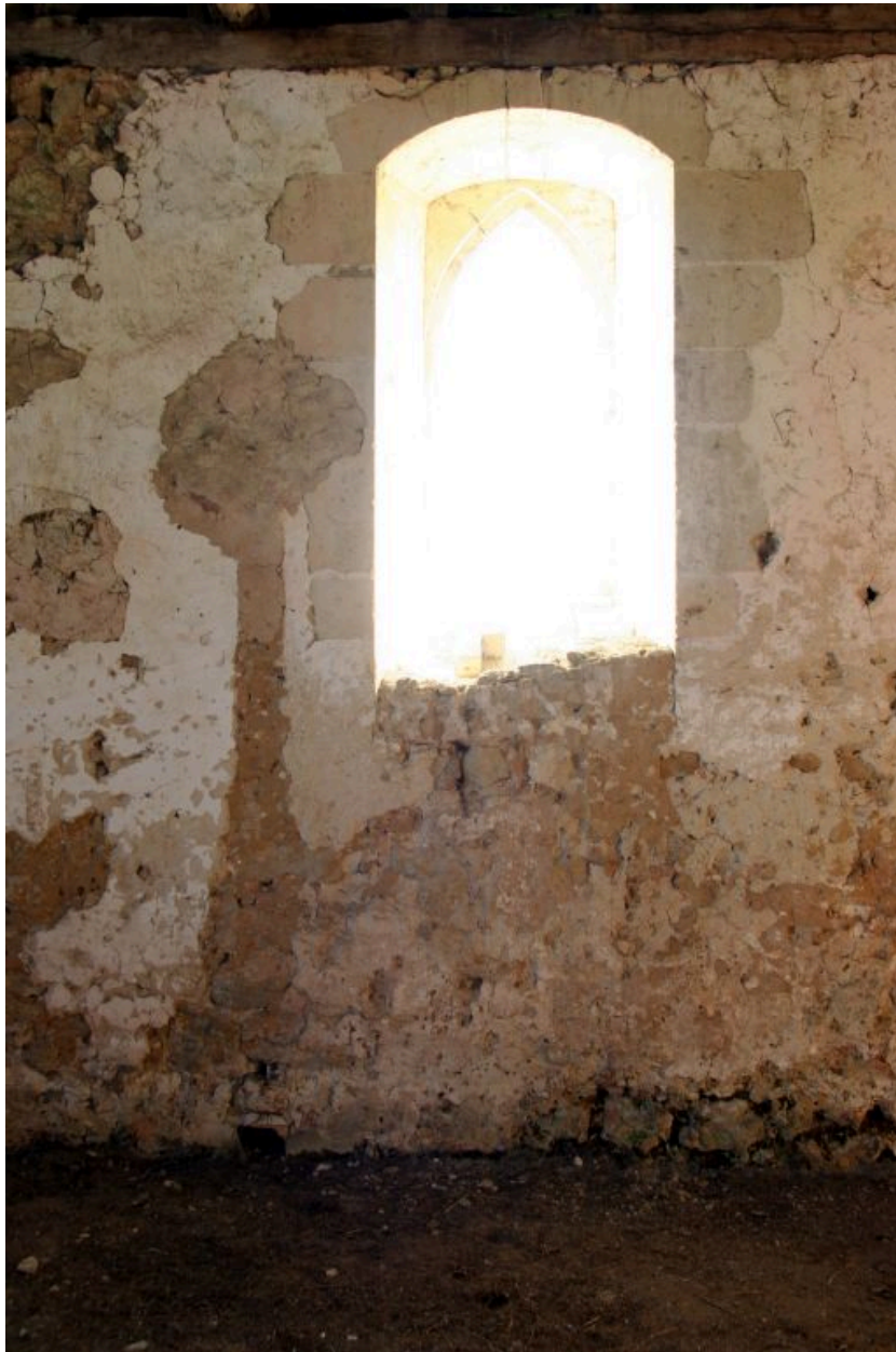
Mur sud de la nef : baie en arc brisé.
