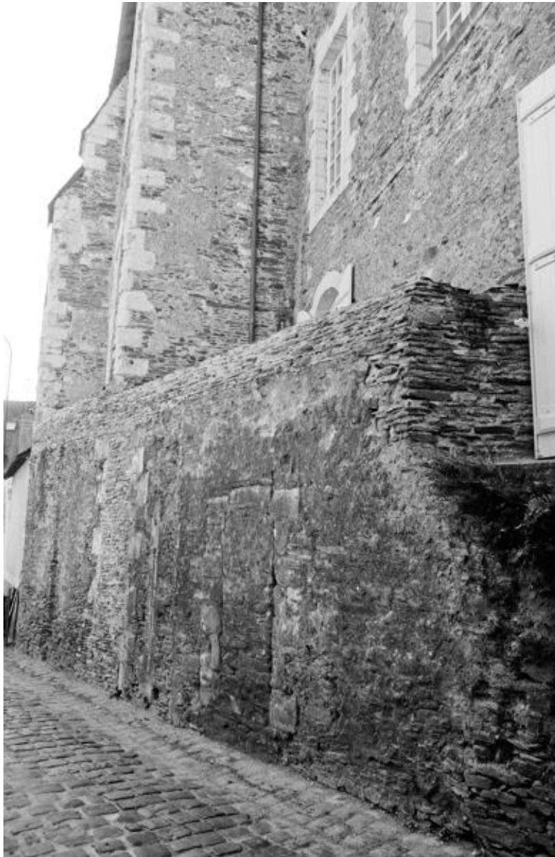
Mur de clôture le long du bâtiment conventuel, sur la rue des Augustins, vue d'ensemble depuis le nord.
