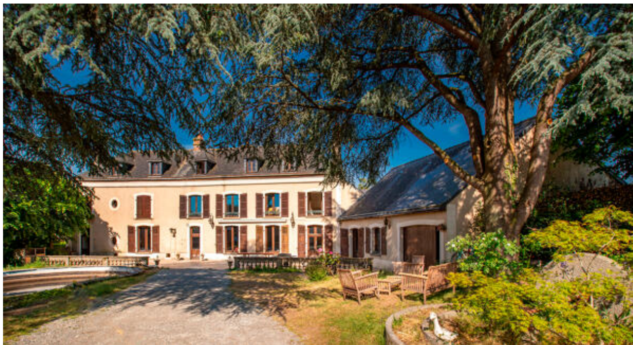
Façade orientale du corps de logis nord-sud.
