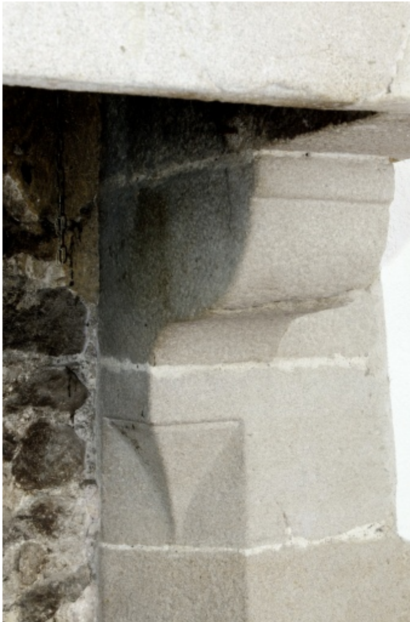
Cheminée nord au rez-de-chaussée, détail du jambage.
