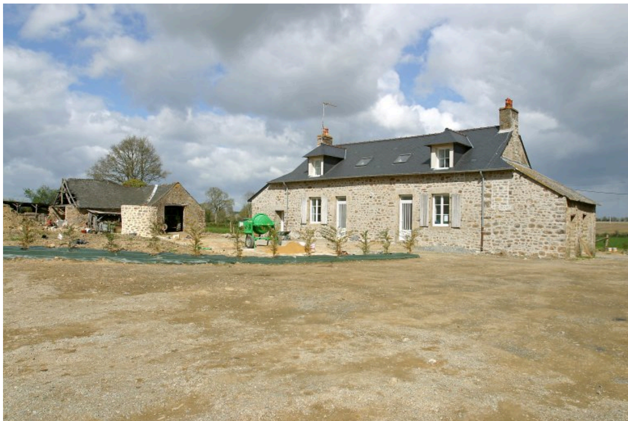
La Grande-maison-Neuve : la remise et le logis.
