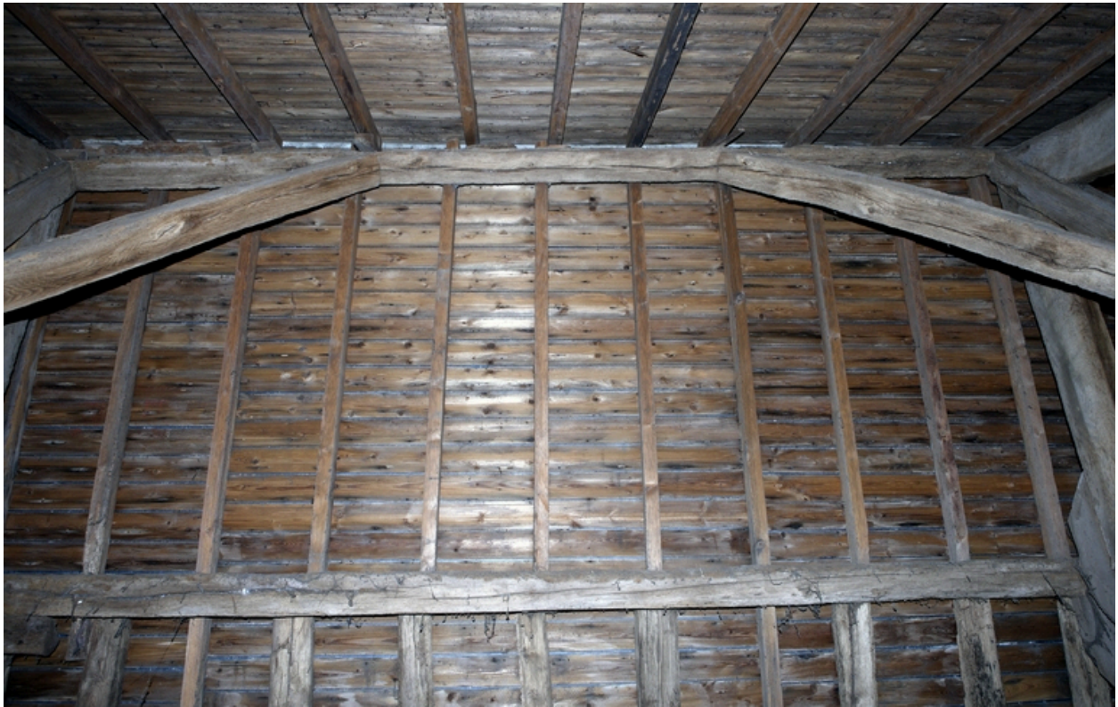
Charpente. Détail du sous-faîtage.
