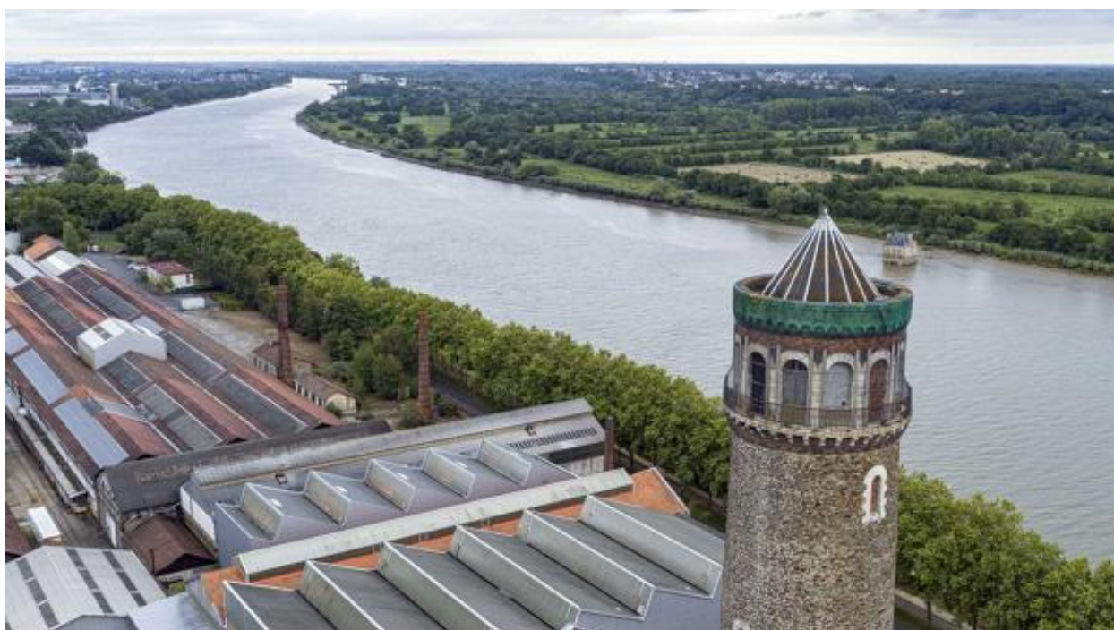
Vue du sommet de la tour à plomb et de la Loire vers l'amont.
