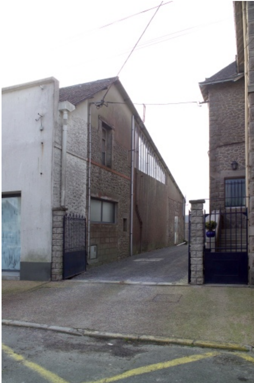
Hangar et chemin conduisant à l'écurie.
