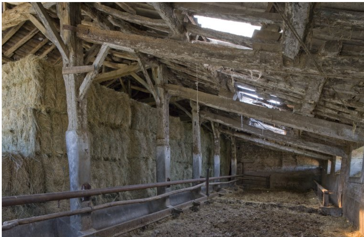
Vue intérieure de l'étable.
