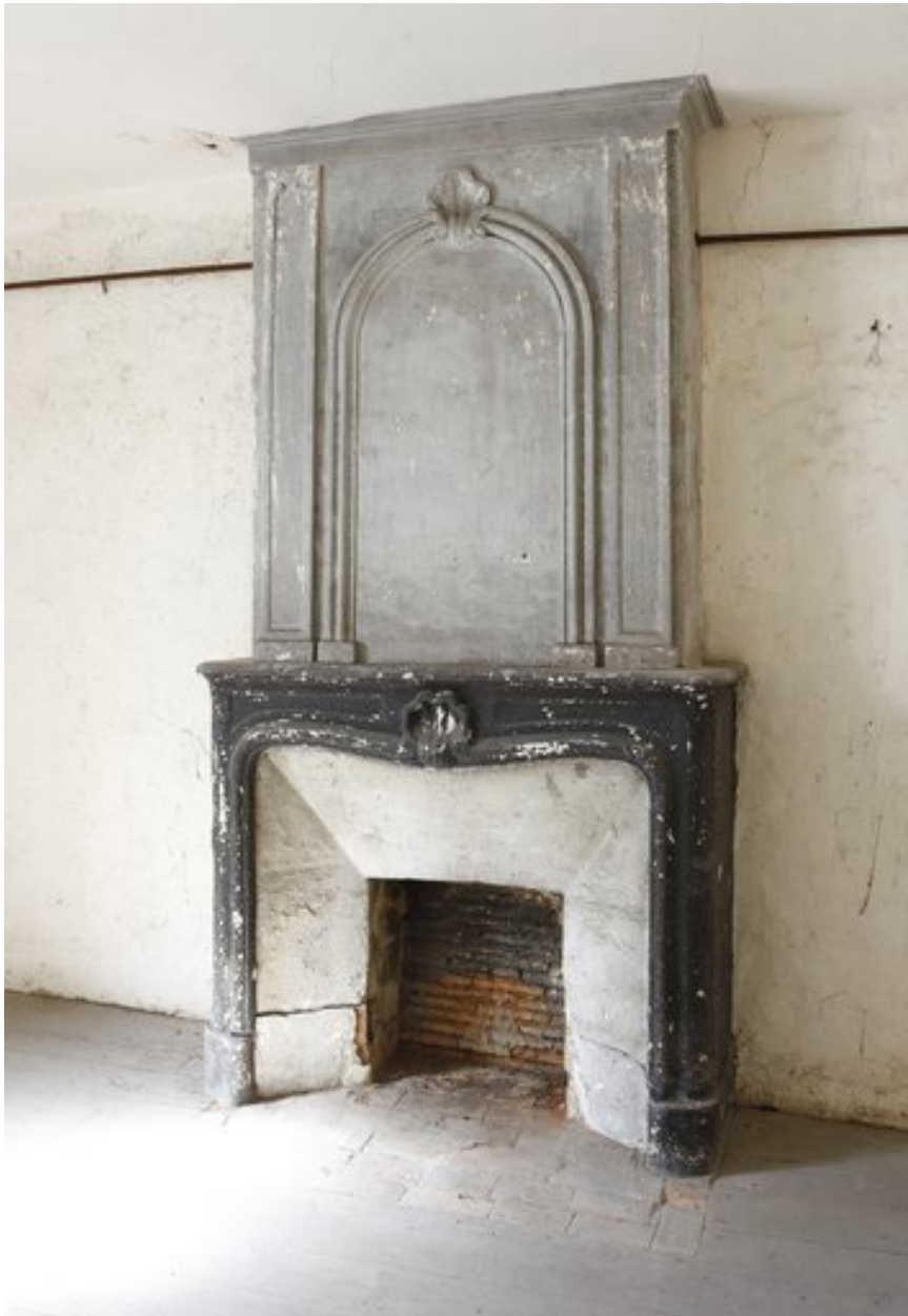
Cheminée de l'une des chambres du premier étage.
