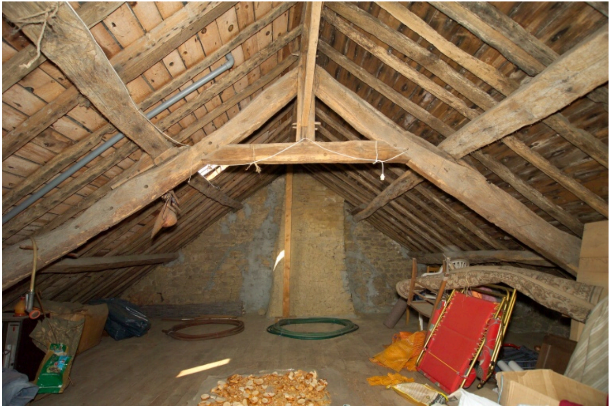
Charpente, vue vers l'Ouest.
