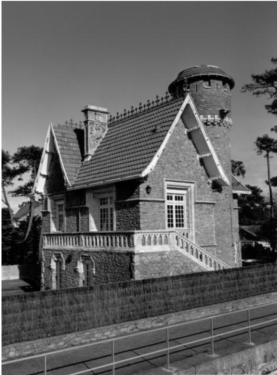
Elévation vue du sud-ouest.
