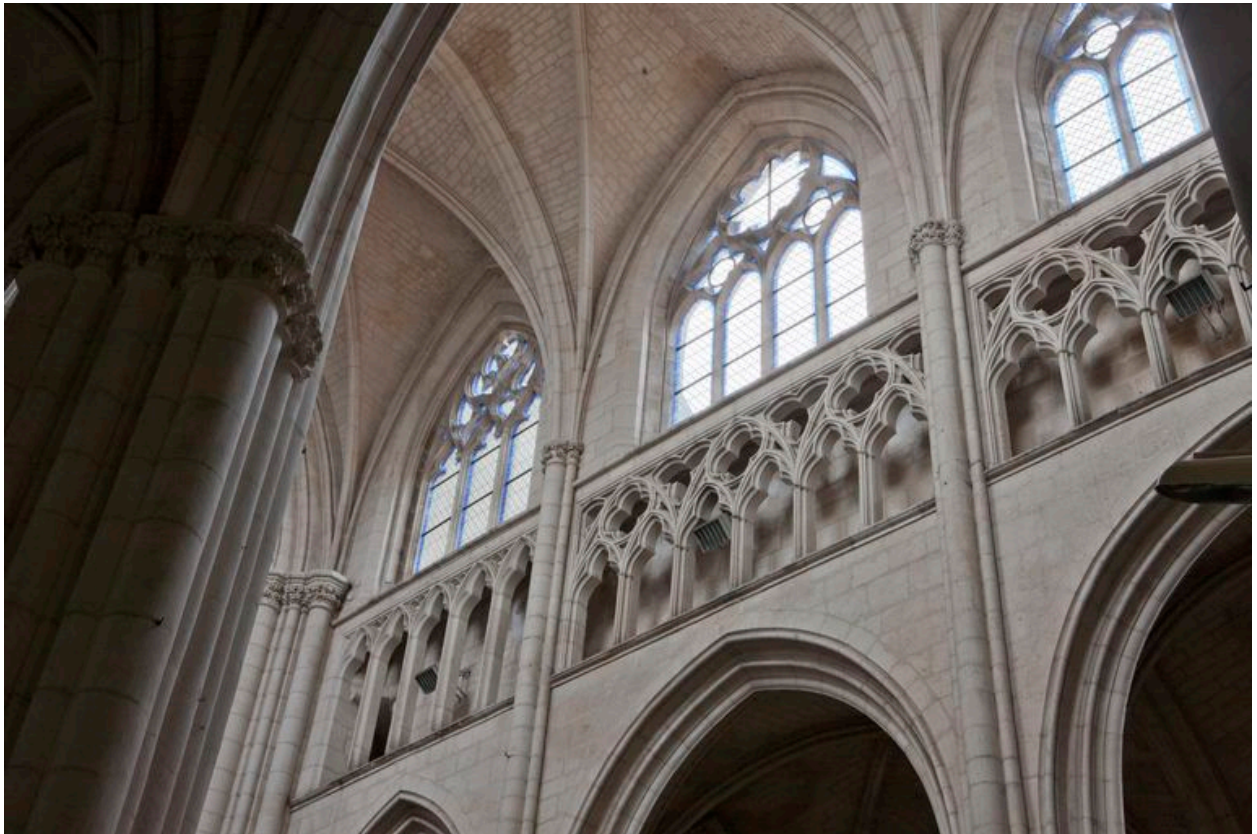
Elévation sud (parties hautes) des troisième, quatrième et cinquième travées de la nef.
