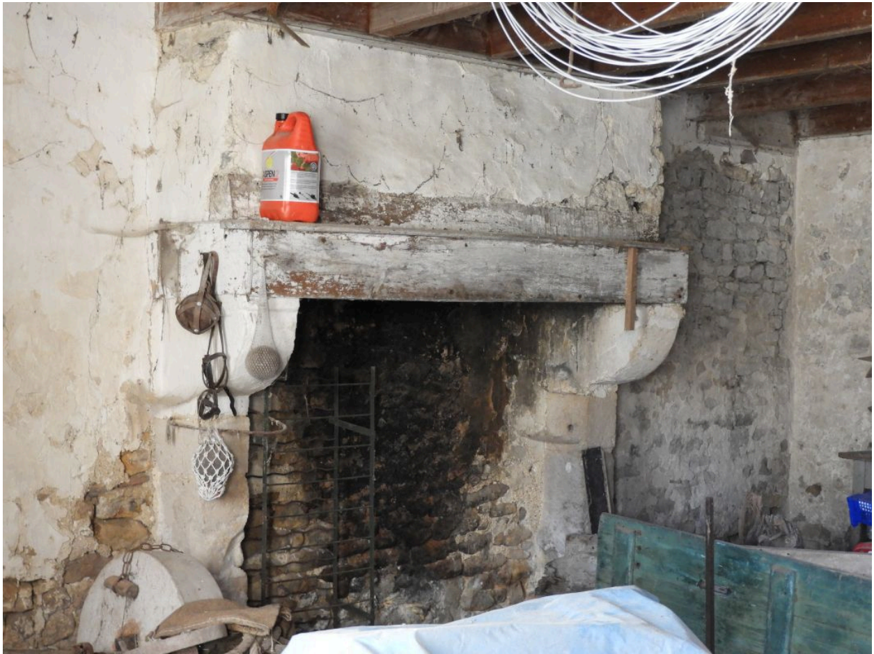
La cheminée à l'intérieur du logis.
