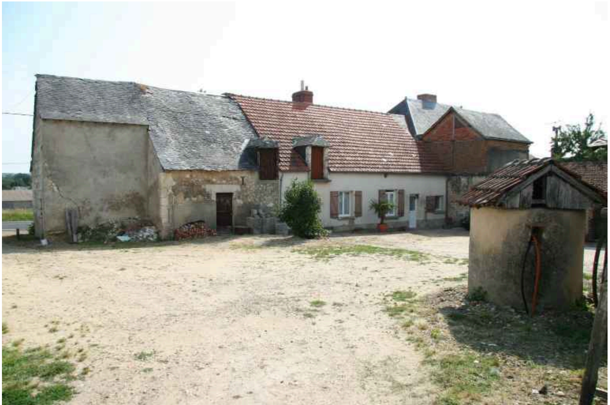
Le Raillon, maison 2 : façade sur cour.
