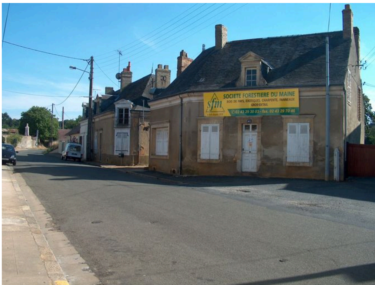
Vue depuis la rue des maisons n°41 à 49, construites entre 1890 et 1900.
