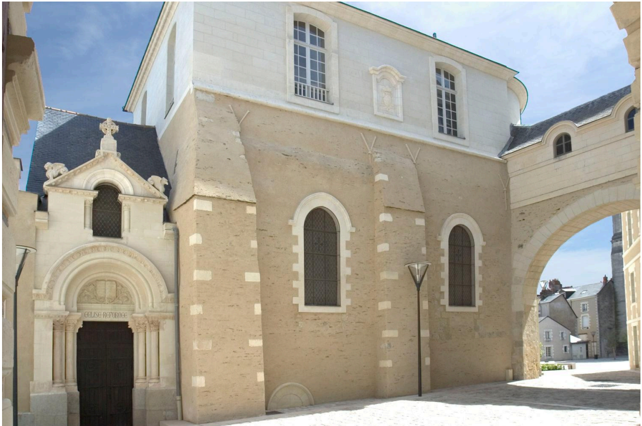
Chapelle saint-Eloi. Elévation extérieure sud après restauration.
