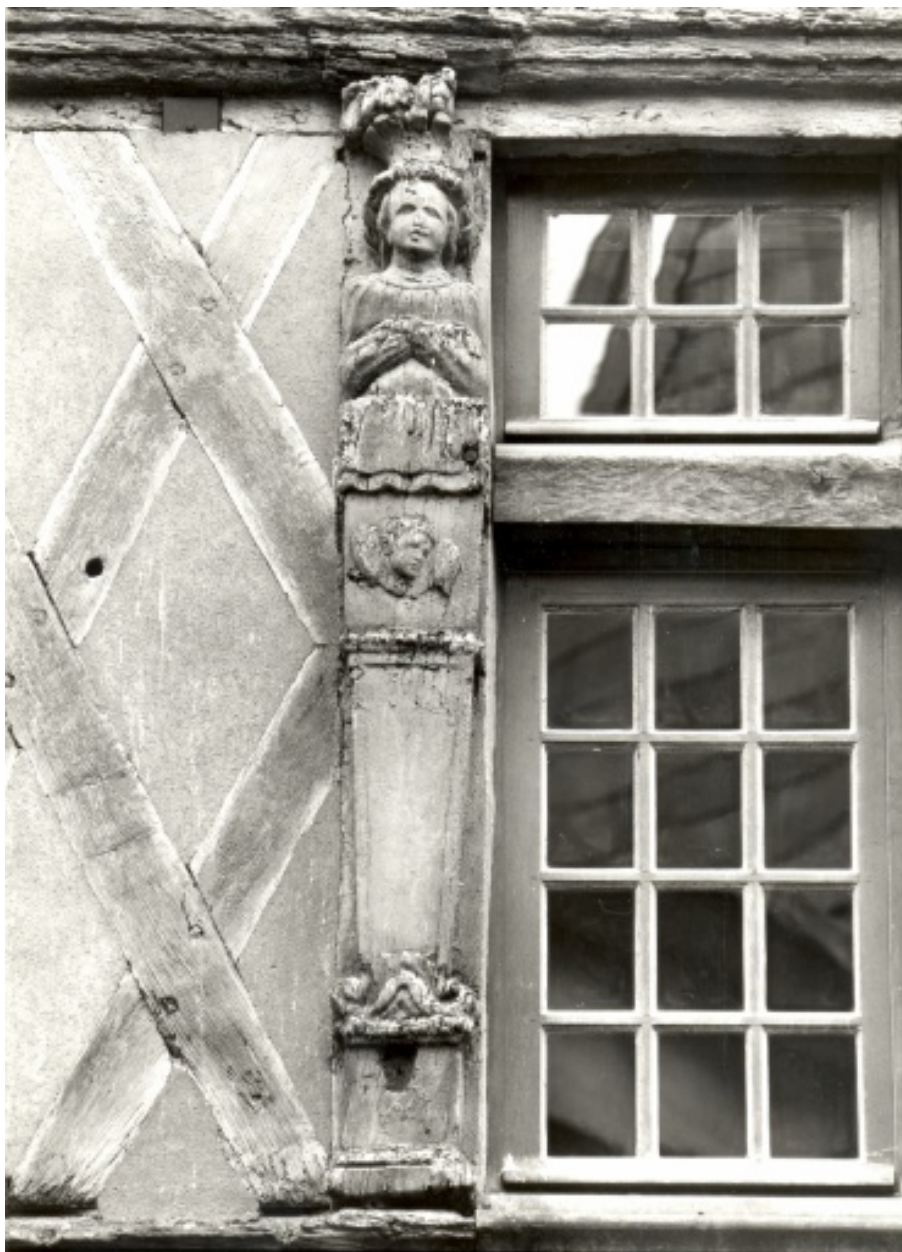
Façade sur rue, 1er étage, baie de droite : support anthropomorphe de gauche.
