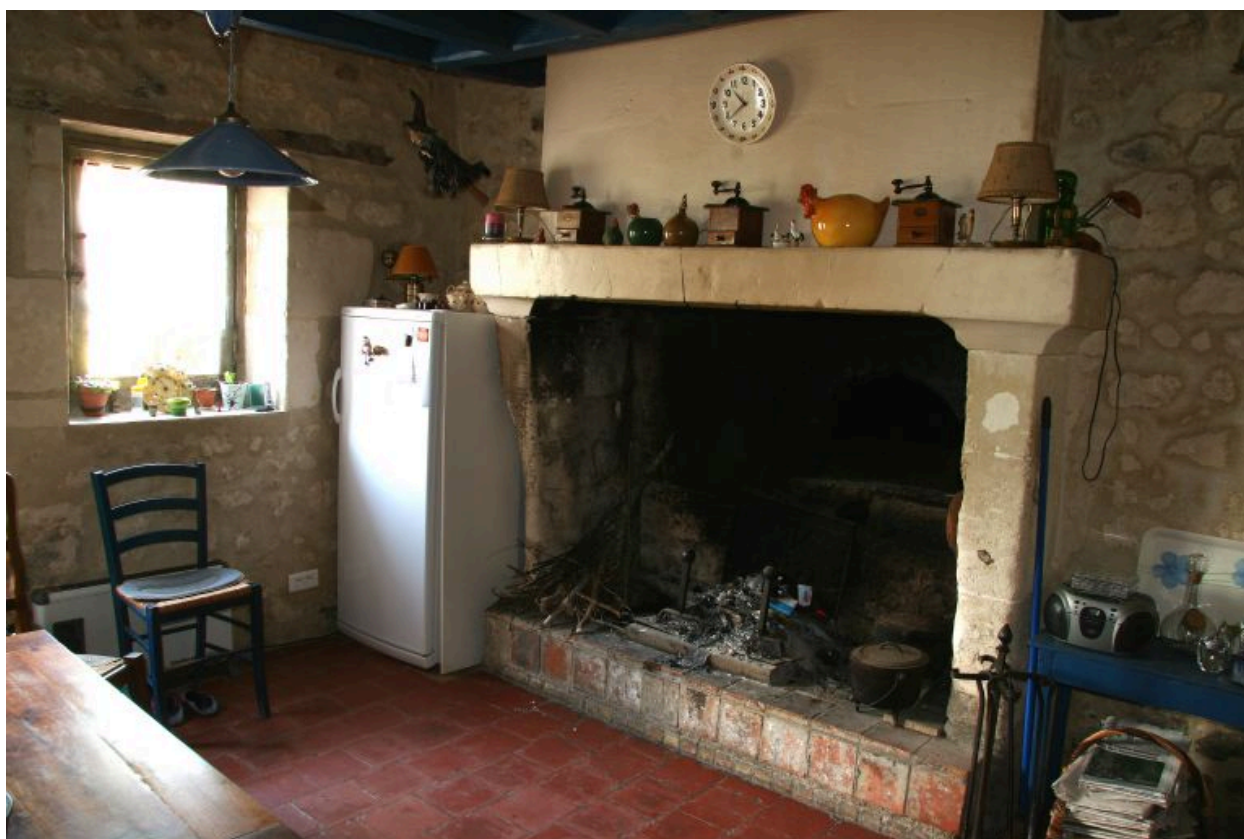
Second logement : cheminée.
