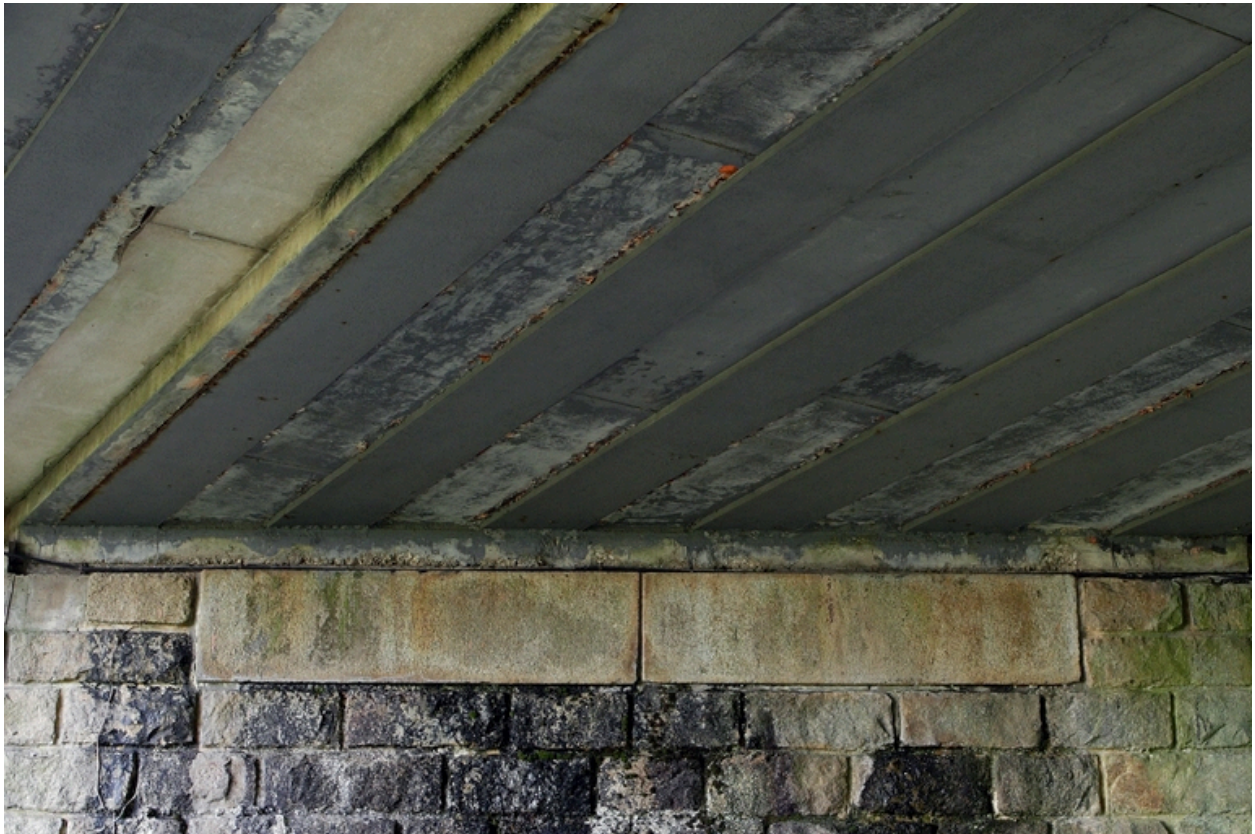
Poutrelles métalliques enrobées dans le béton, vue inférieure.
