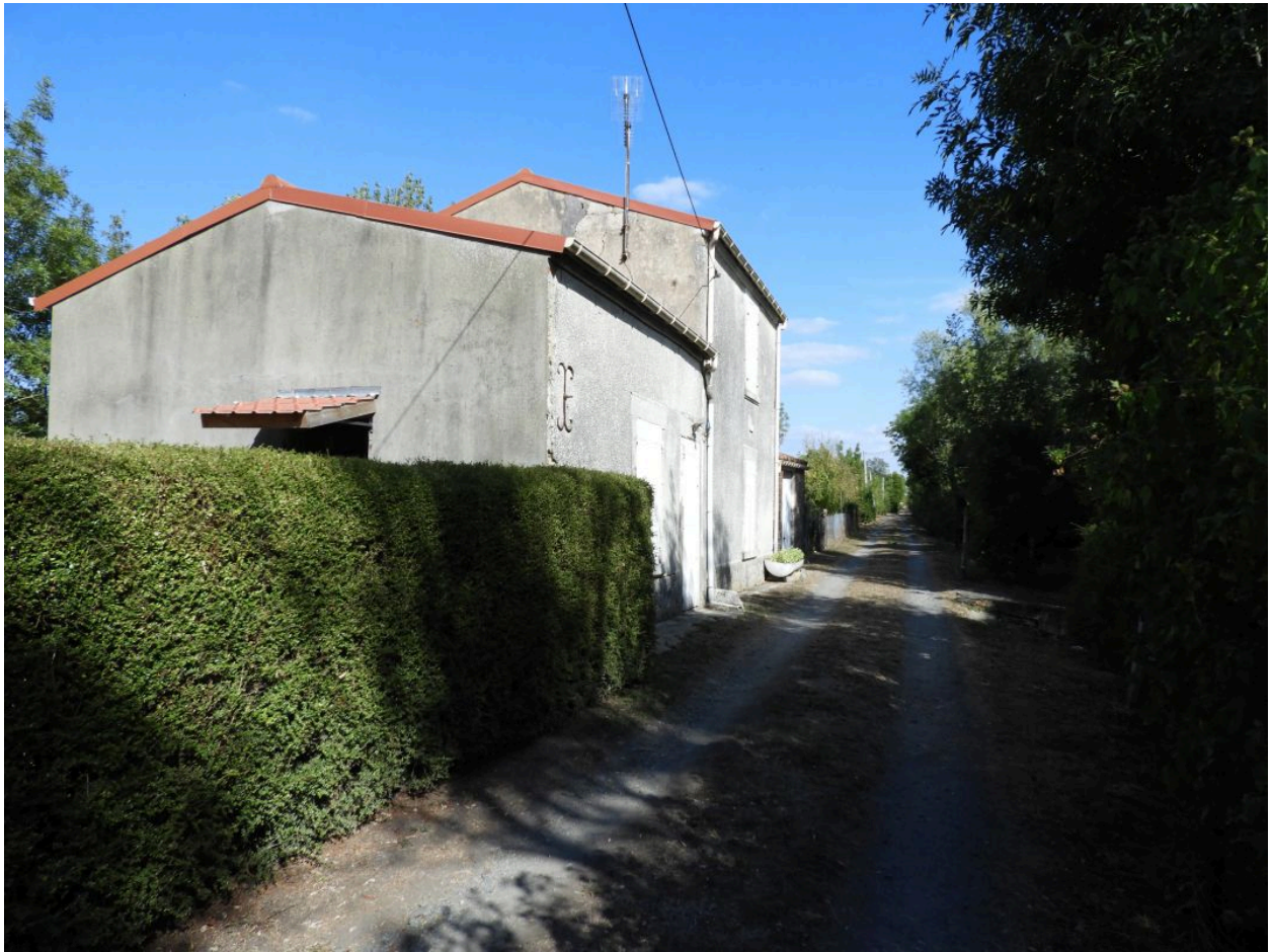
La hutte vue depuis l'ouest.
