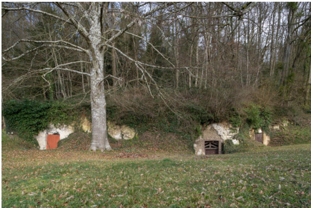
Aménagements troglodytiques dans le coteau.
