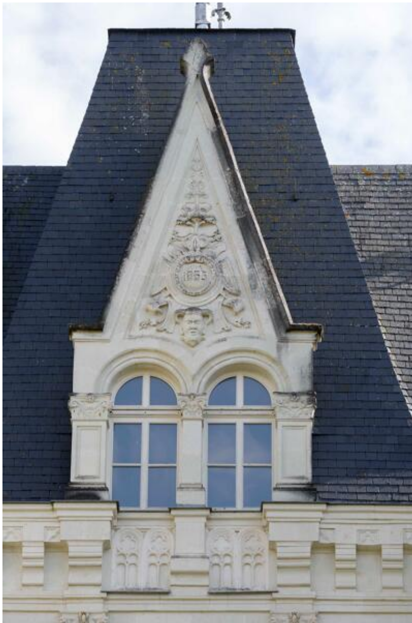
Détail d'une lucarne haute triangulaire à fleuron portant la date de 1863 avec baie géminée, lucarne centrale, façade principale.
