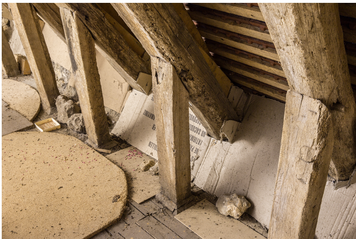
Un détail de la base de la charpente.
