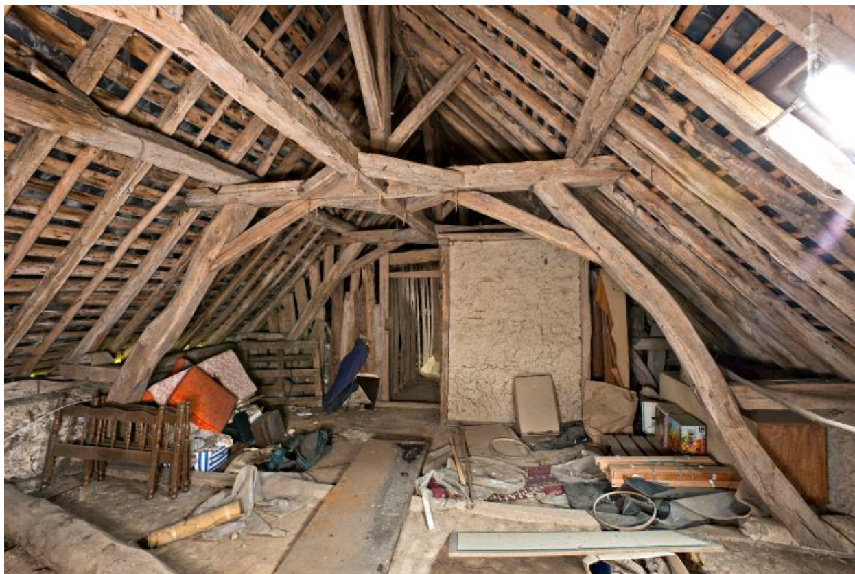
Comble : charpente vue depuis l'ouest.
