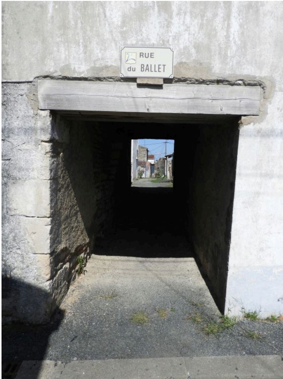
Passage couvert entre la rue Moinard et la rue du Ballet.
