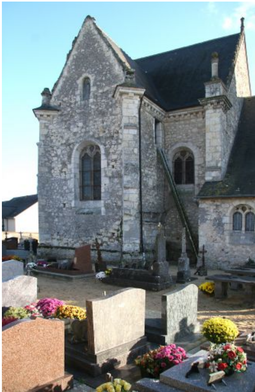
Façade septentrionale : bras gauche du transept.
