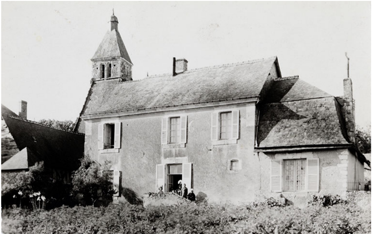
Le presbytère, élévation sud.
