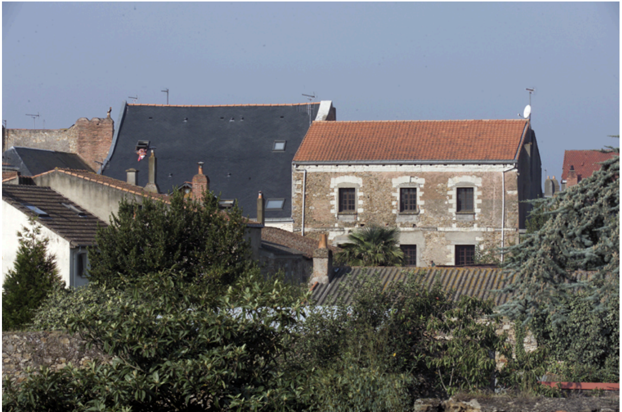
Les façades postérieures n° 21 et n° 19 (de gauche à droite).
