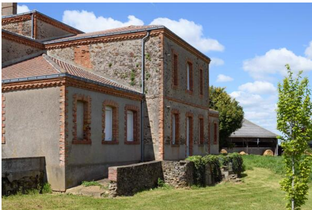
Vue de la façade est.
