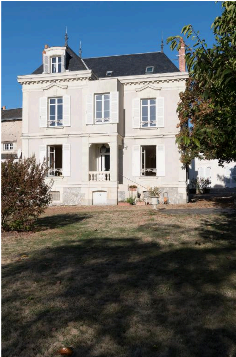
Vue de la façade sur la Loire.
