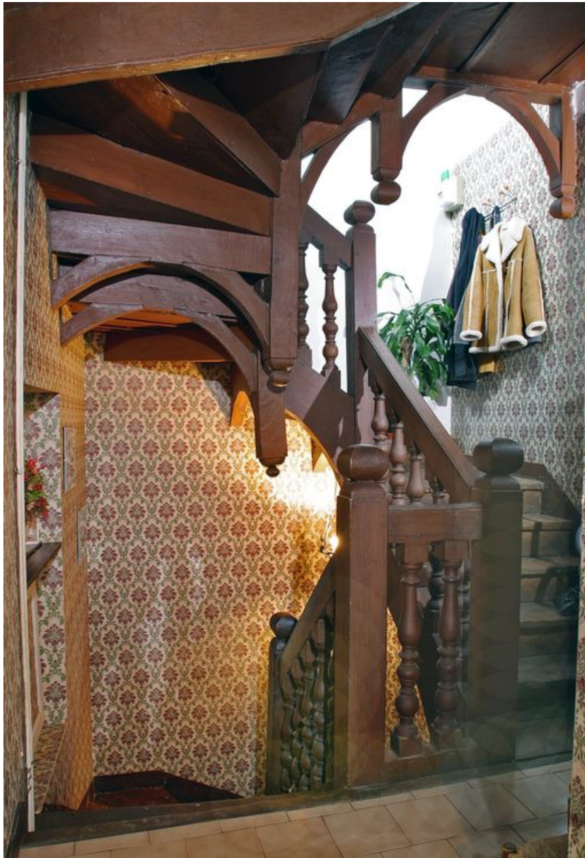
L'escalier vu depuis le couloir du premier étage.
