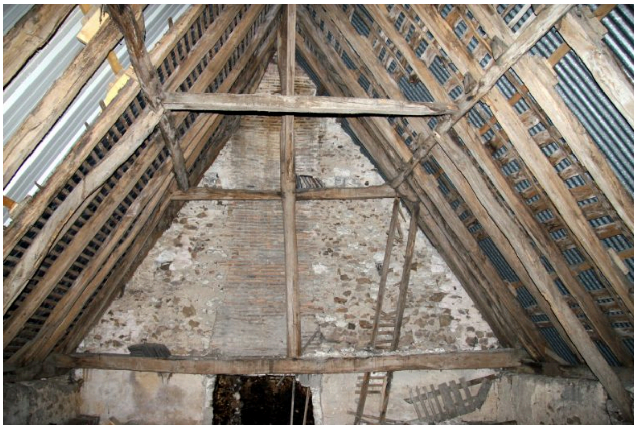
Charpente à pannes et encoches.
