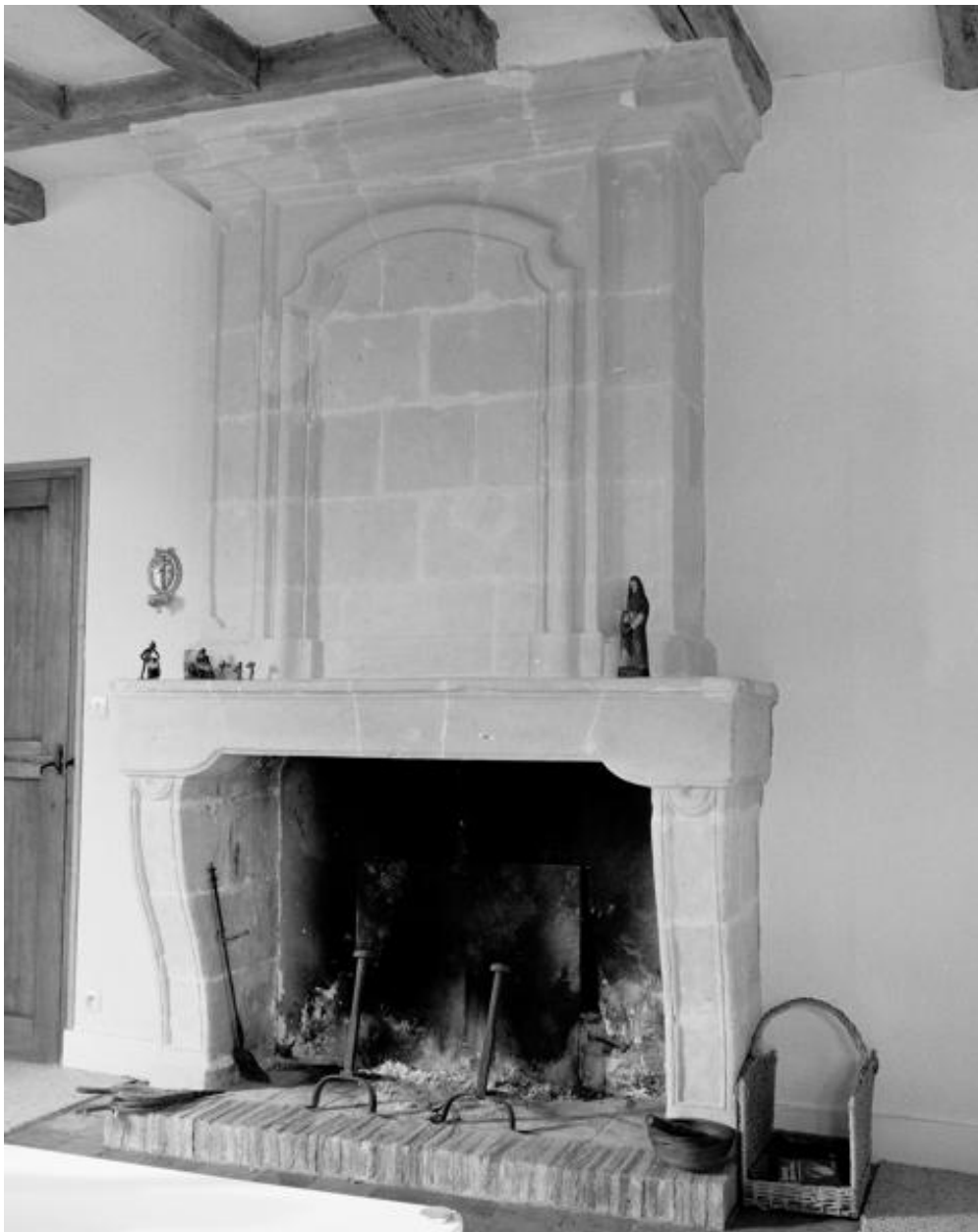
Vue d'ensemble de la cheminée du rez-de-chaussée.
